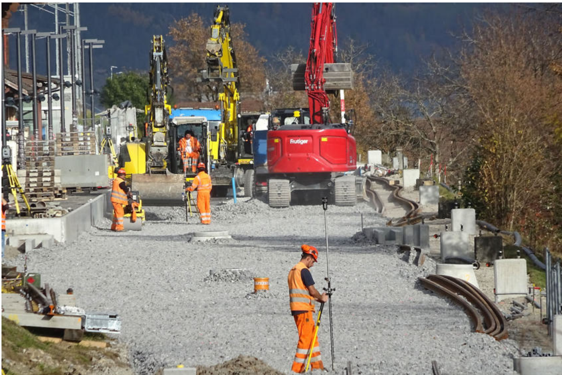
Umgehend wurde eine dritte Schicht Schotter aufgebracht als Träger der Betonschwellen. So gewaltig die Bagger aussehen, lässt sich doch sehr exakt arbeiten.
