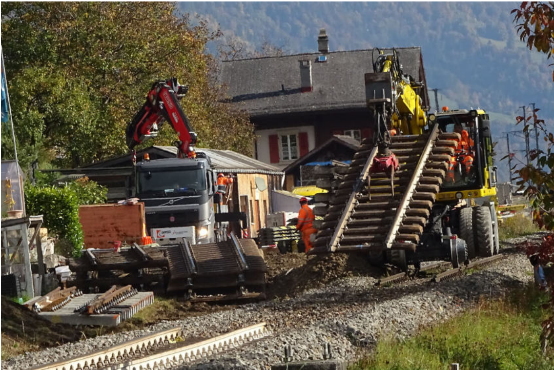
Umgehend begann der Rückbau. Die bereitgelegte Weiche zeigt den herrschenden Optimismus!
