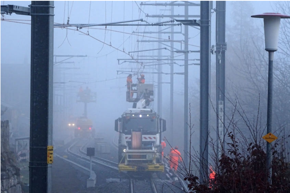
Die Fahrleitungen wurden montiert.
