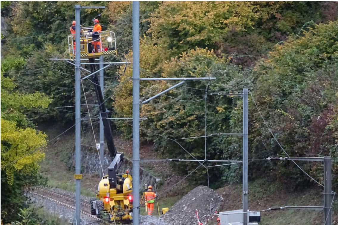
Die Fahr-, Erd- und Speiseleitungen wurden abgebaut.
