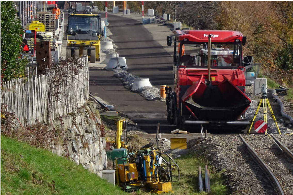
Die zweite Lage Überzug wurde anschliessend asphaltiert.
