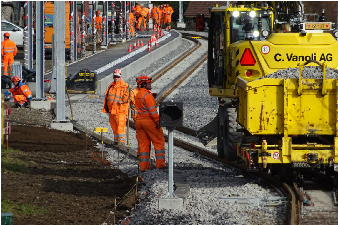
Es folgten Arbeiten an der Umgebung, der Anschluss vom Billetautomaten und das Giessen von Leitlinien.
