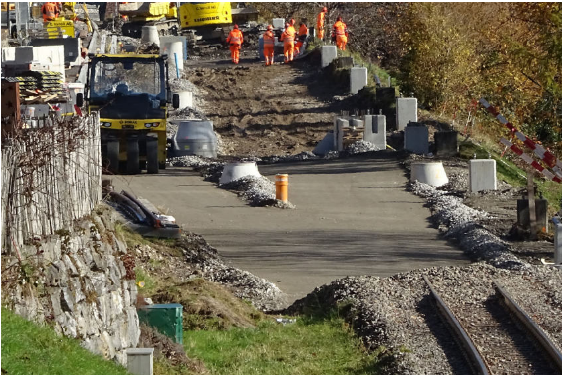
Diese Planie wurde geglättet.
