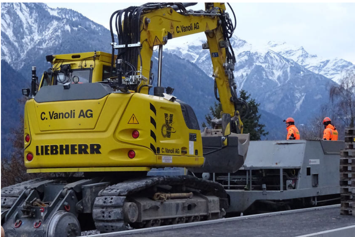
Links die 'Lok' (Zweiwegebagger), rechts ein Schotterwagen aus der Sicht eines 12-Jährigen.
