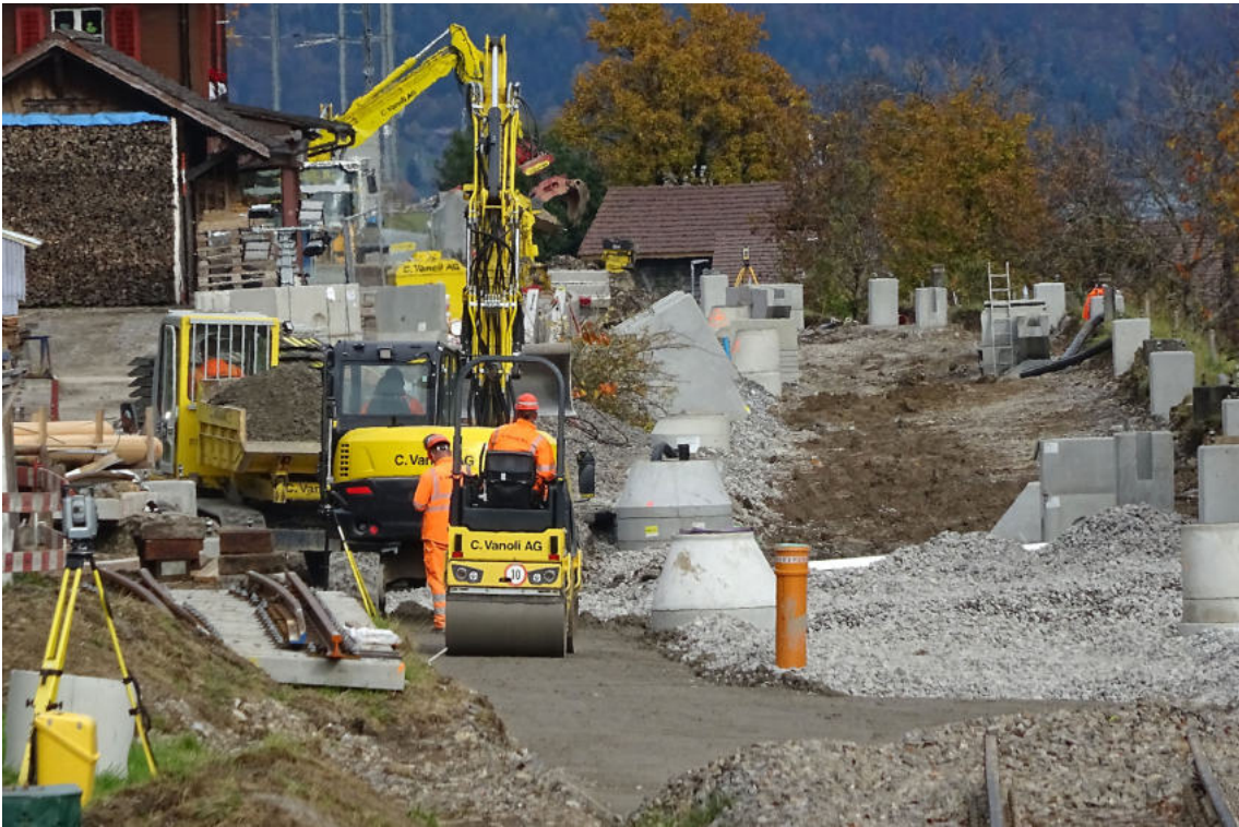
Es wurde Schotter und darauf Planie eingebracht.
