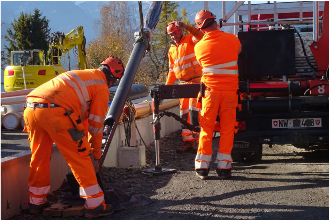
Im ganzen Gewusel wurden u.a. auch der neue Perron betoniert ...
