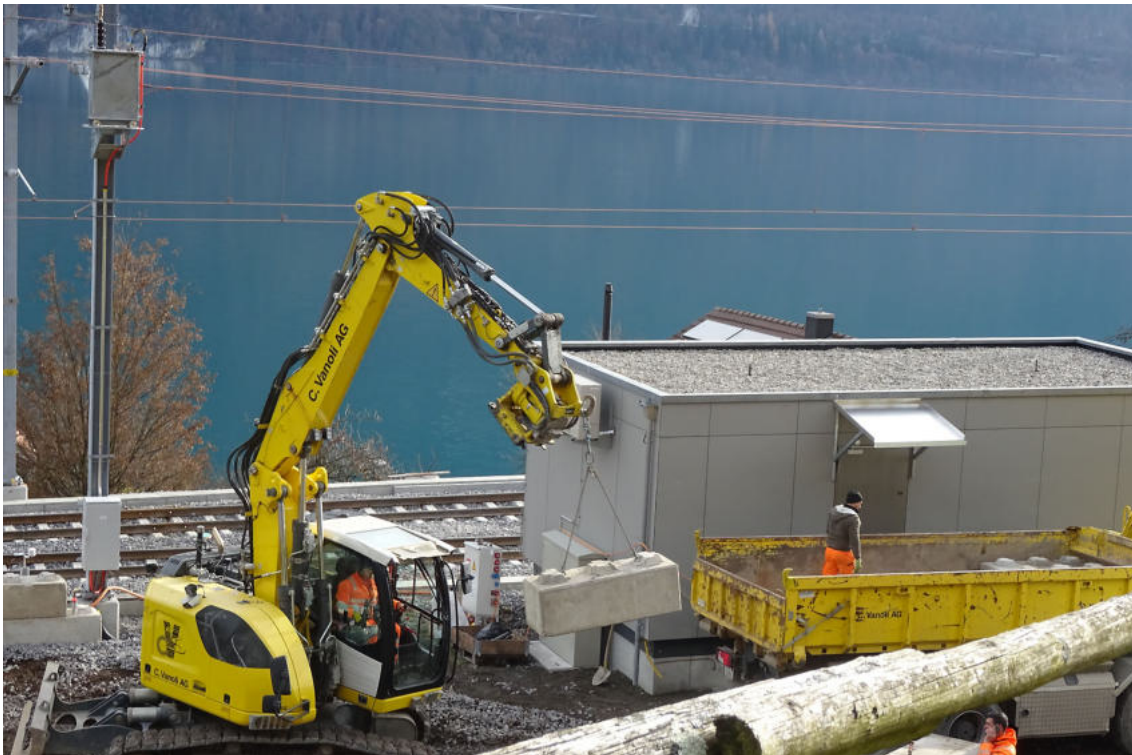
Dieweil wurde die Baustelleninstallation weggeräumt.
