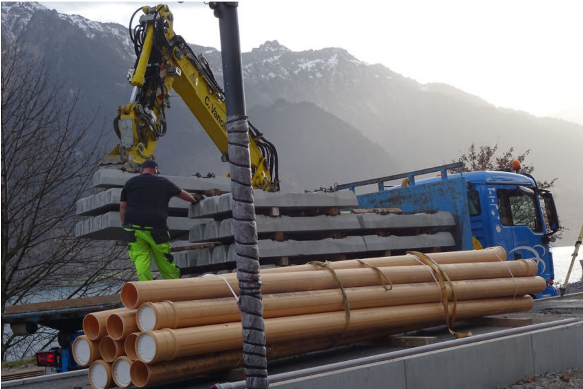
Die Schwellen wurden bereitgelegt...
