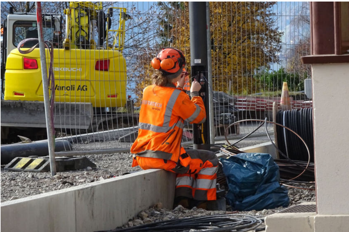
... und die Kandelaber gestellt und angeschlossen.
