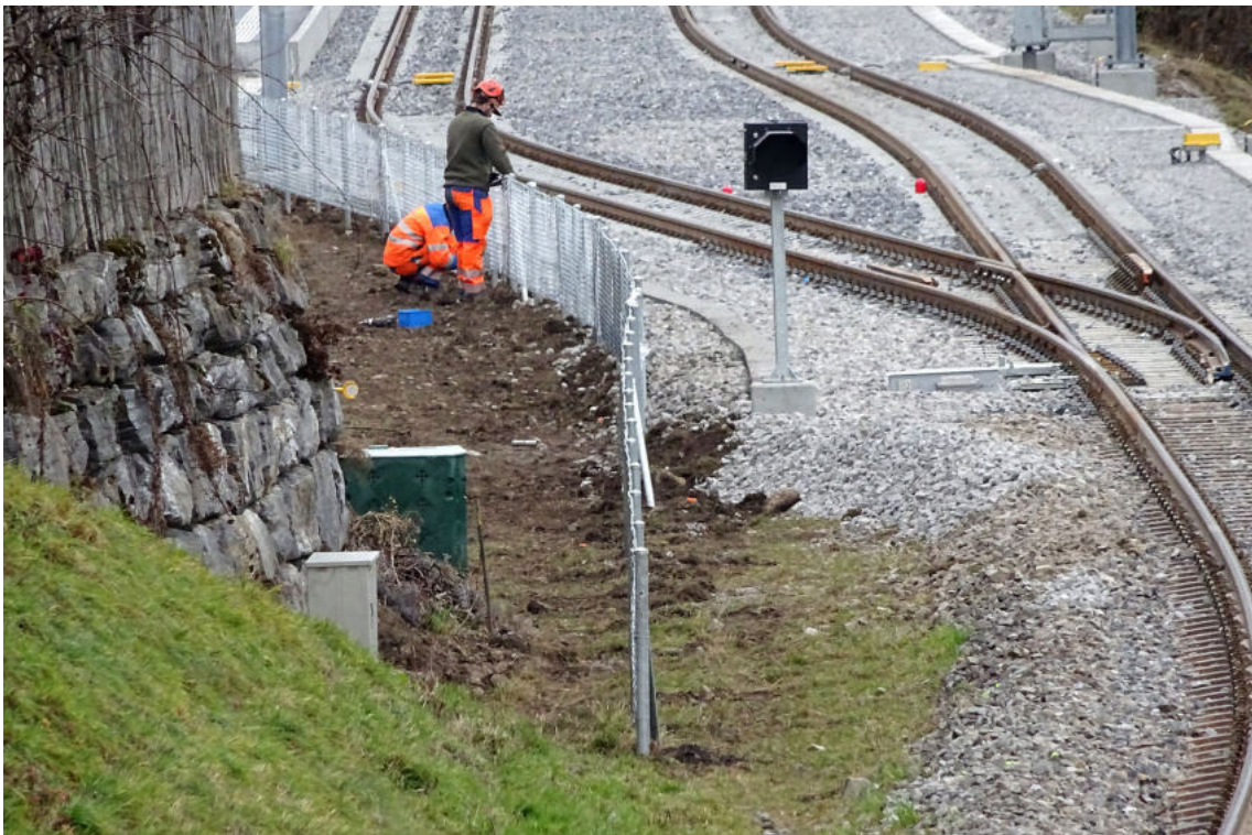
Der Schutzzaun wurde fixiert.
