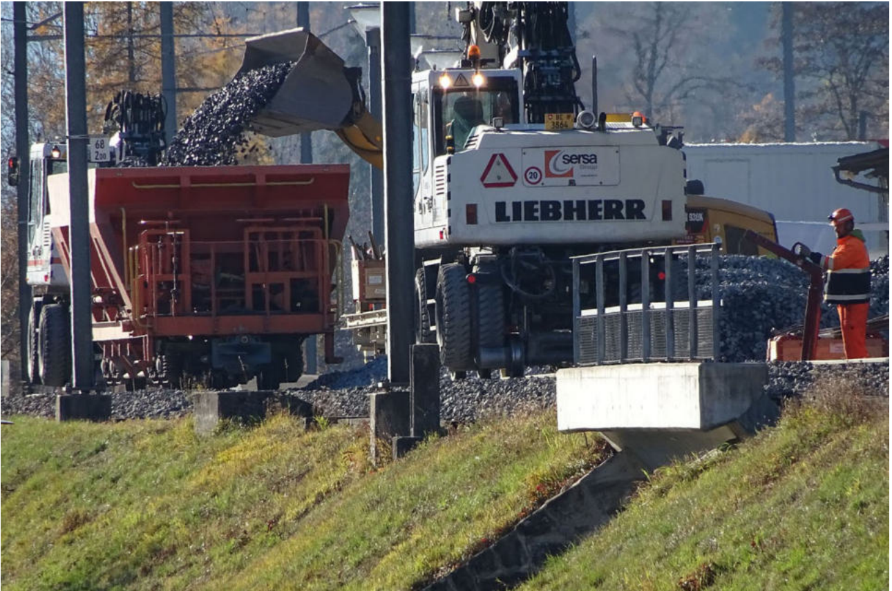
Schotterverlad, davor die 'früher' erneuerte Mätteligrabenbrücke.
