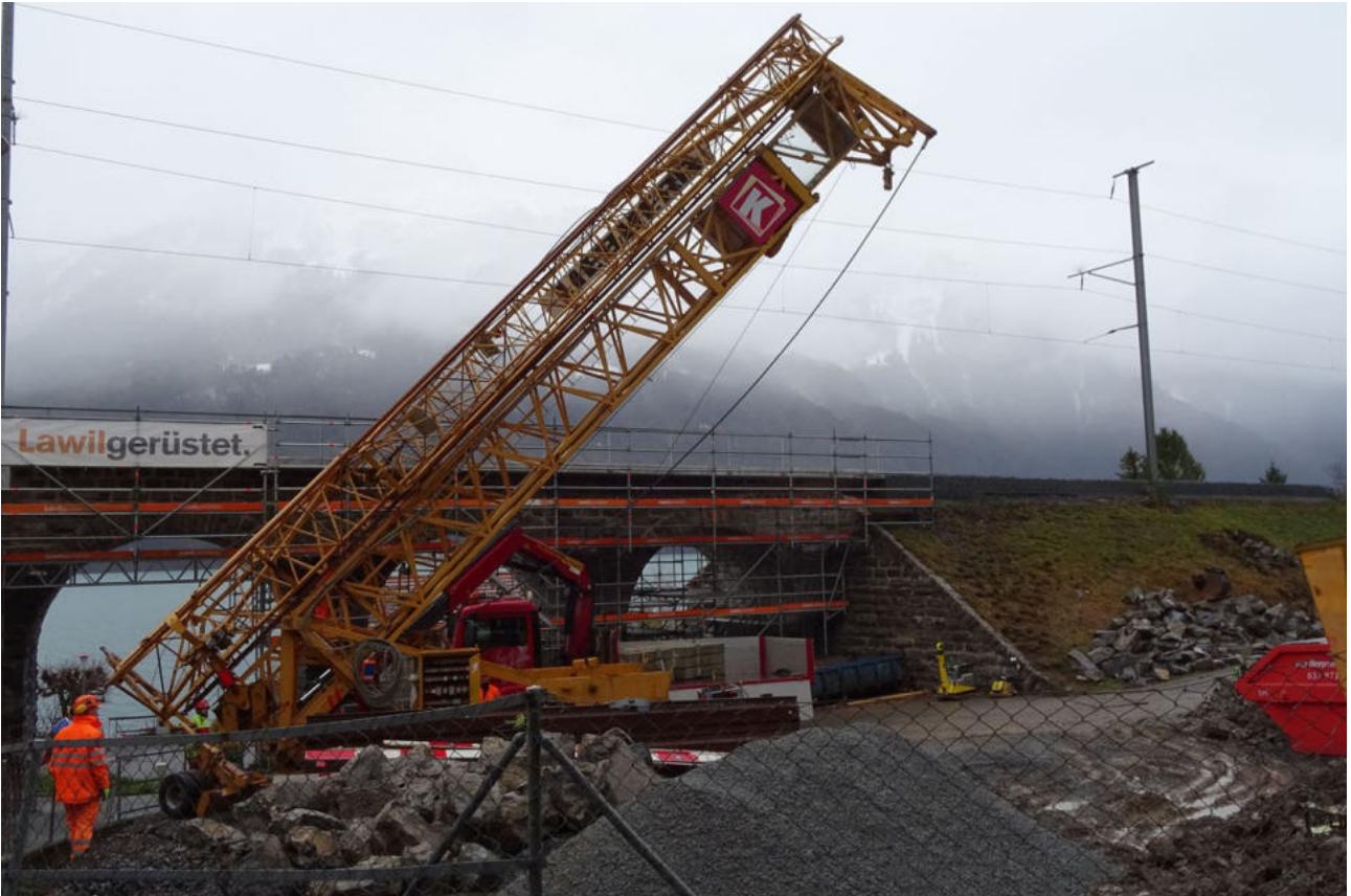
Beim Kranabbau im Mätteli regnete es ausnahmsweise.
