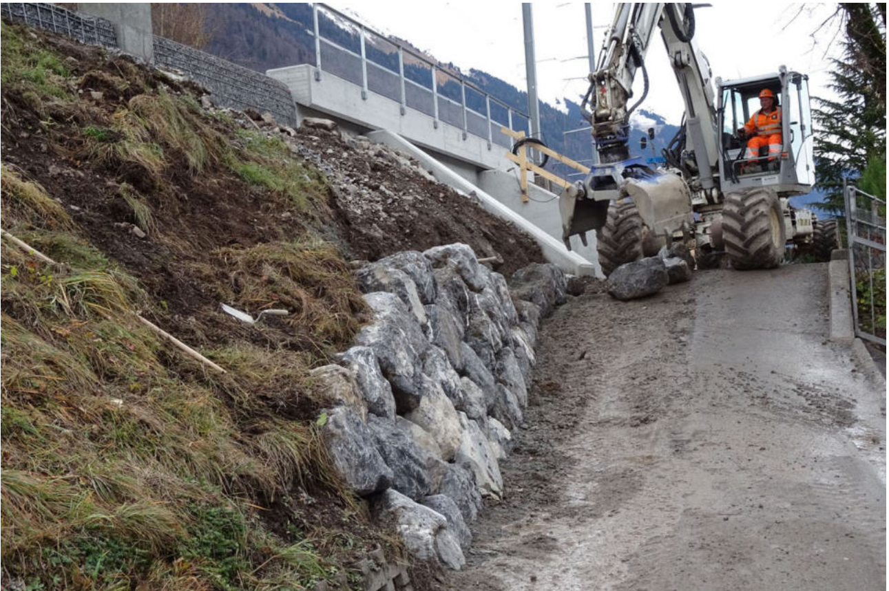
Die zb stützte den Damm ab, was Niederried eine bessere Strassenführung gestattet.
