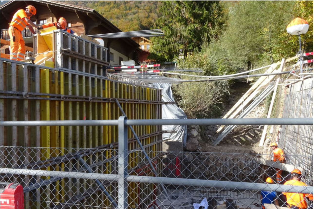
Die Raindlgrabenbrücke wurde komplett neu gebaut:
