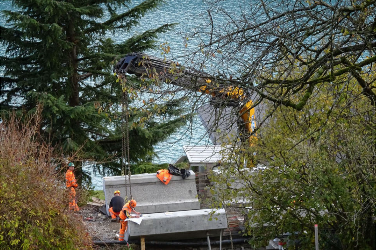
Ebenfalls der Durchgang im Schoren wurde ...
