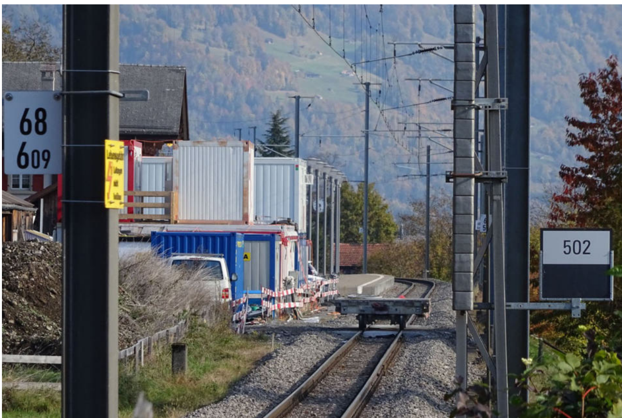
Neu-Niederried beim Bahnhof ...
