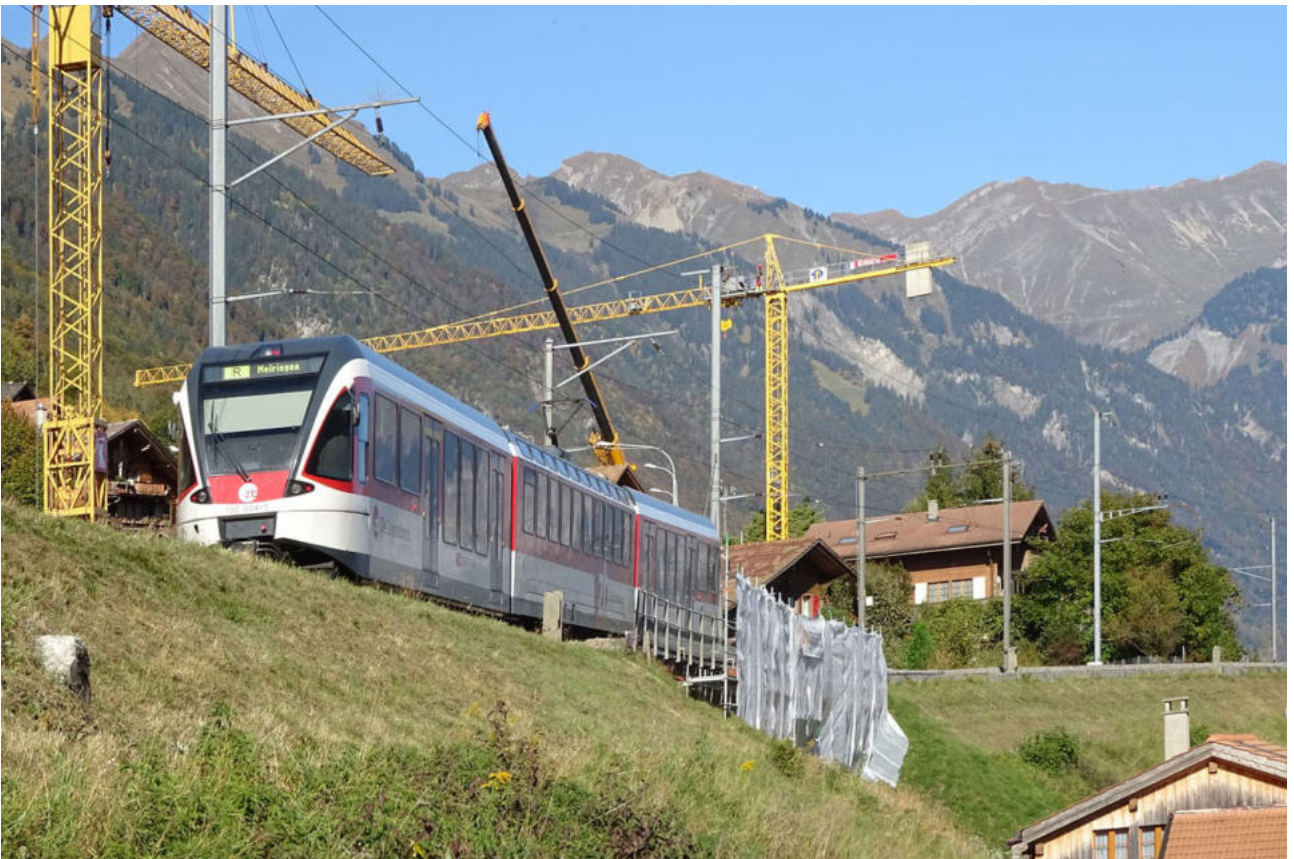
Einer der letzten Züge vor dem Umbau. Kranaufbau bei der Rossgumm.
