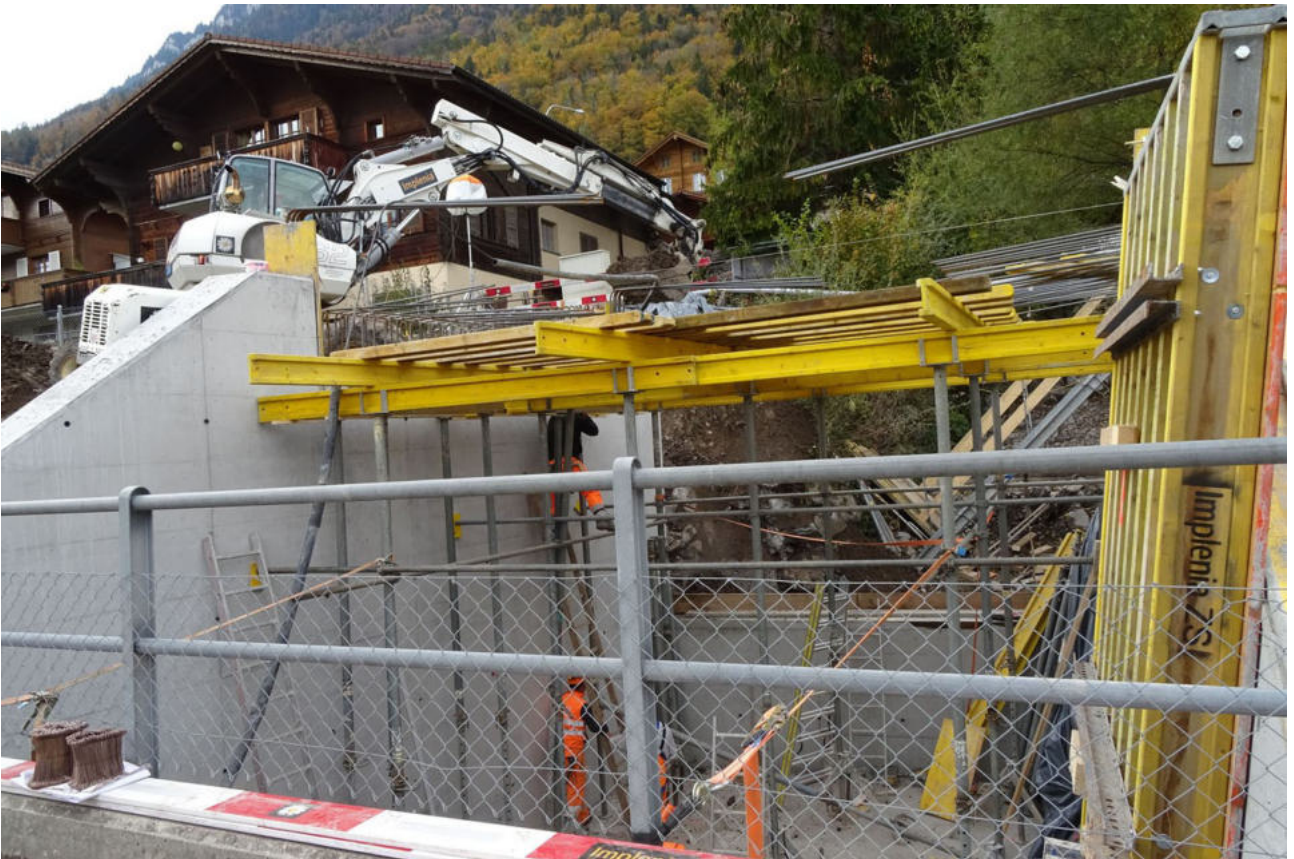
Sohle mit Kasten gegen das Unterspülen, Seitenwände und ...
