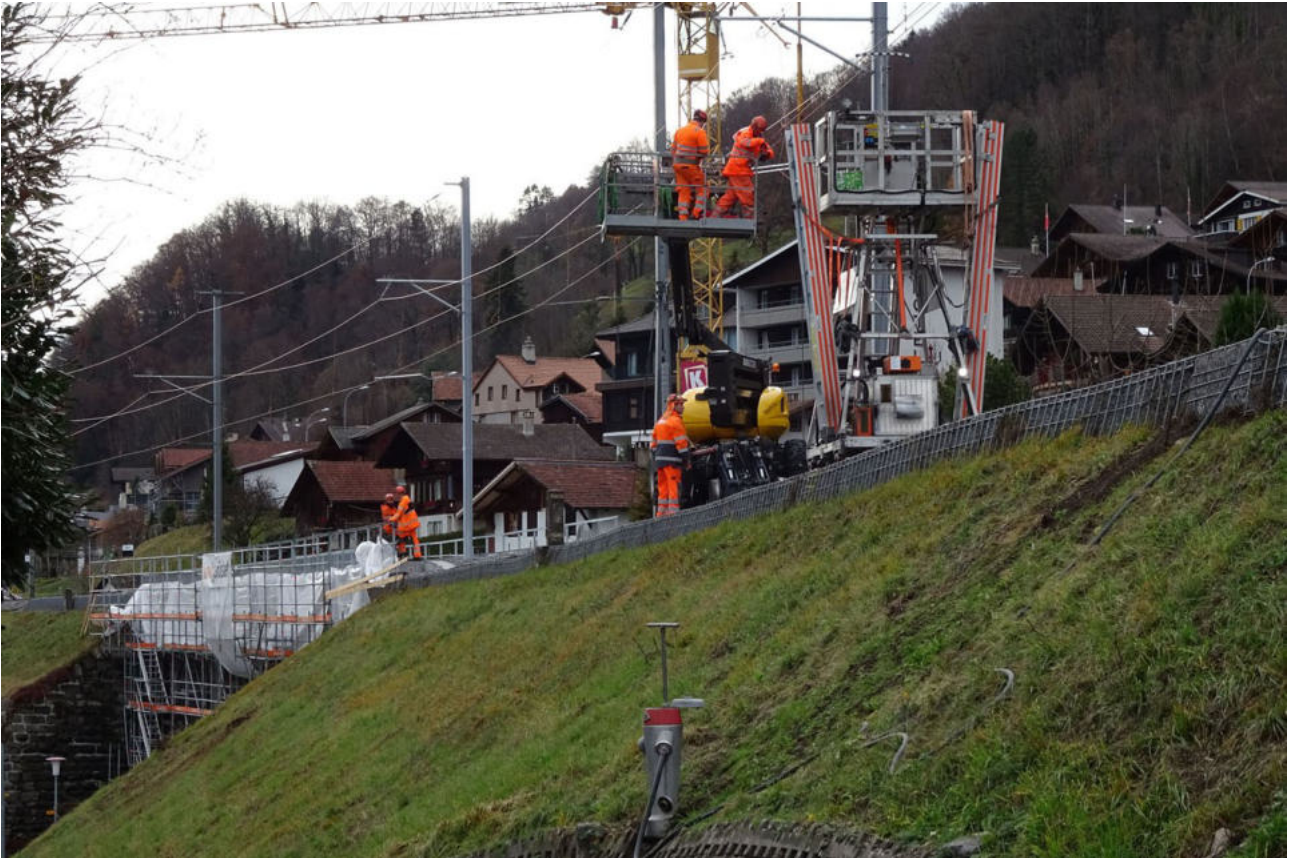
Leitungsbau. Davor der 'Wasserbezugsort mit Geschichte' für den Bauplatz im Mätteli.
