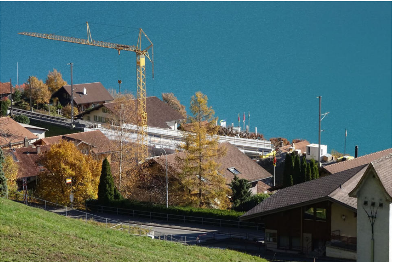
Einer der wenigen Ruhetage im ansonsten straffen Bauablauf.
