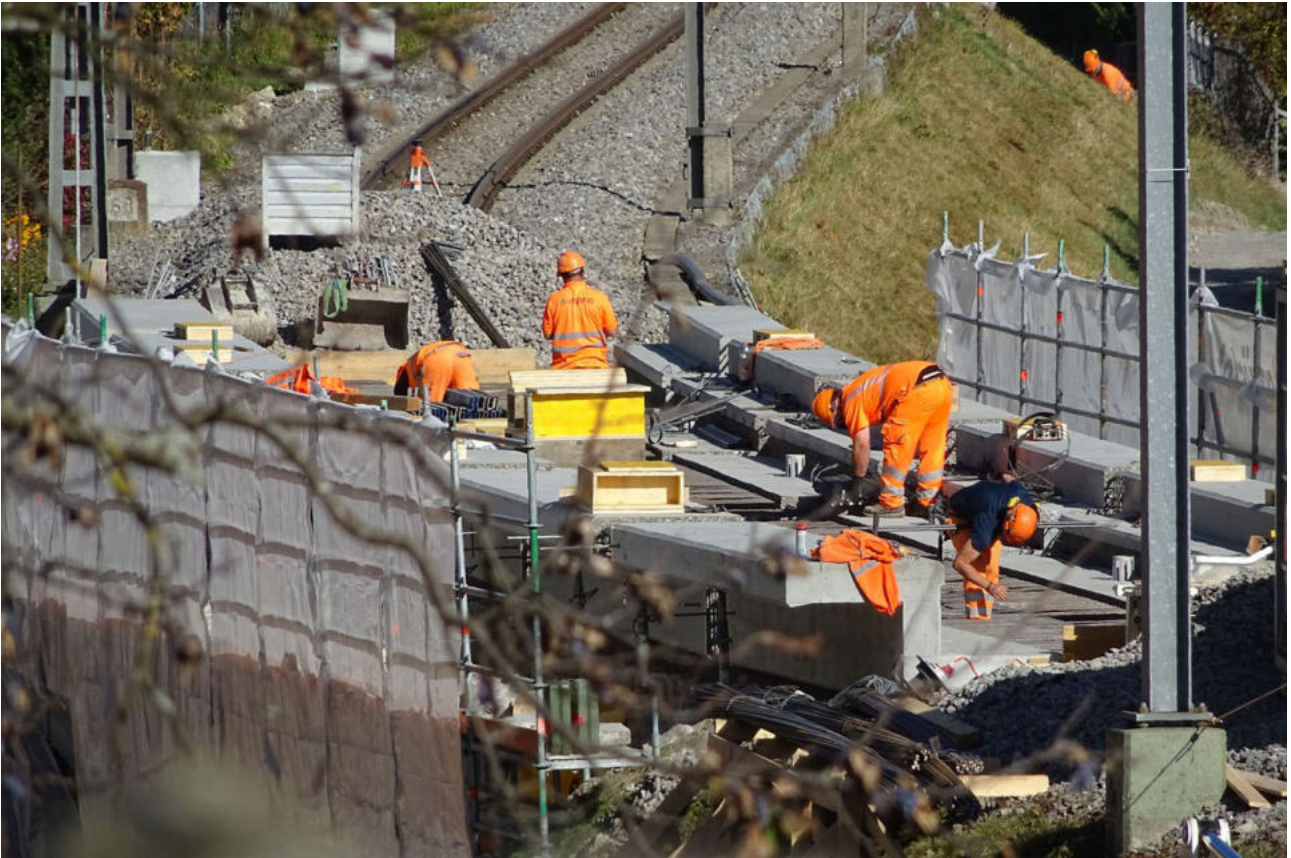
Beim Viadukt in der Dorfmitte wird an der neuen Schale gearbeitet.
