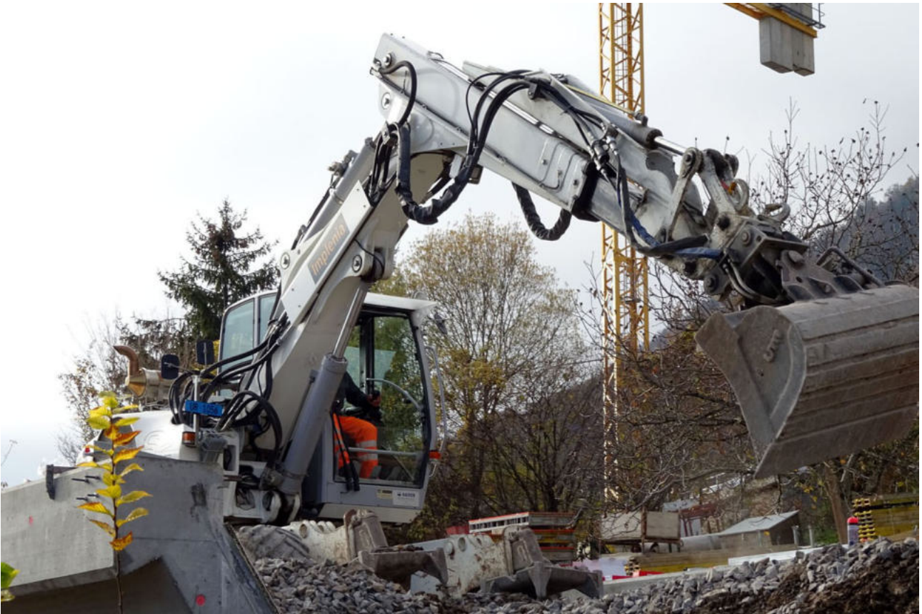
Für die Bauten war das Trasse abzubauen und neu anzulegen.
