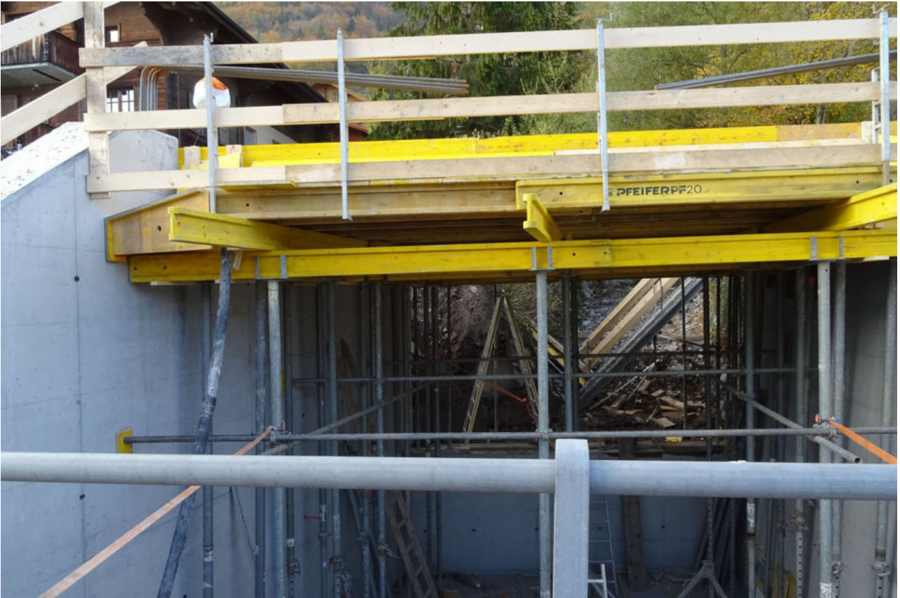
... neuer vor Ort gegossener Brückenkasten.
