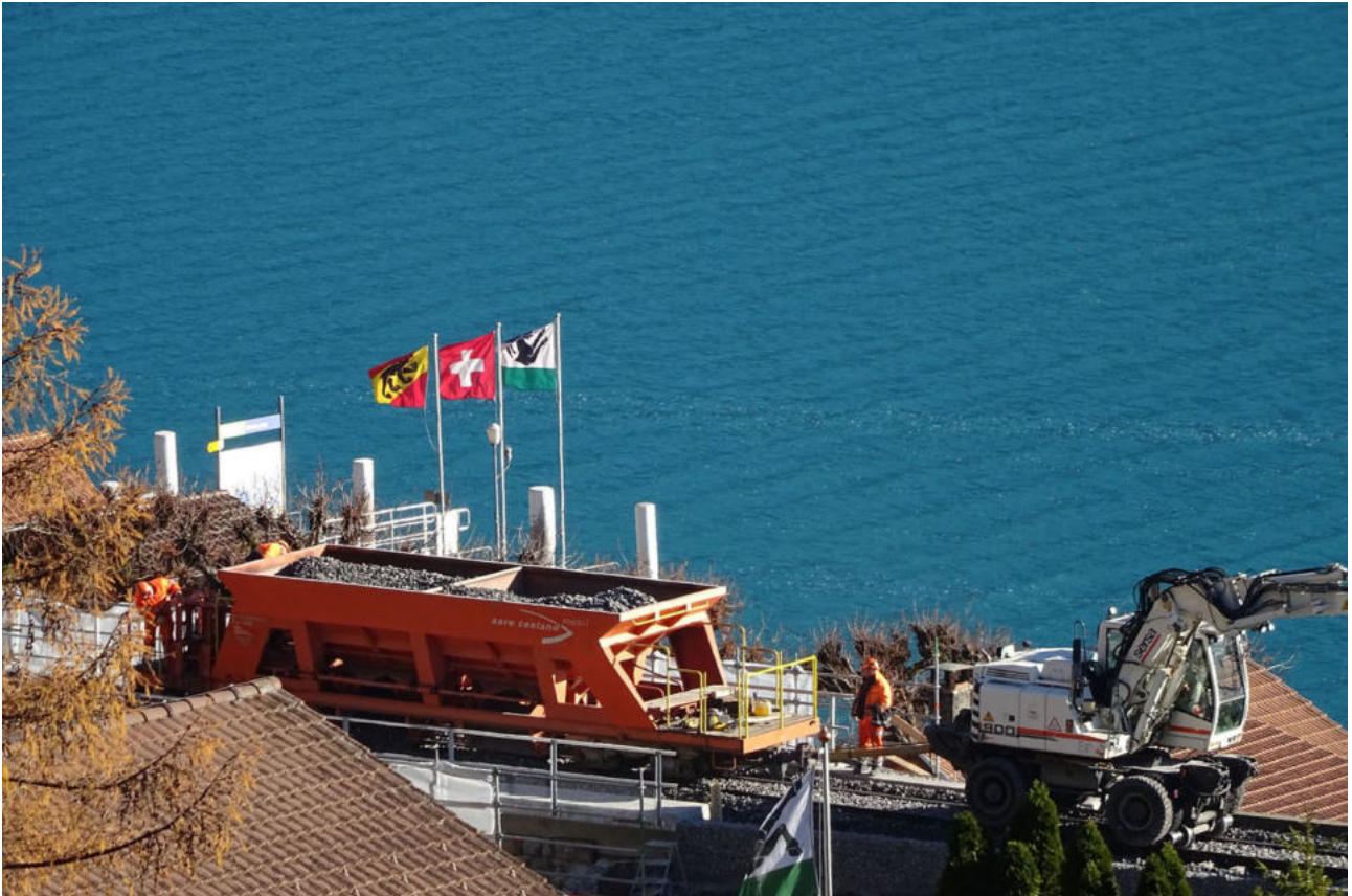
Die Geleise sind provisorisch verlegt; das Schotterbett wird komplettiert.
