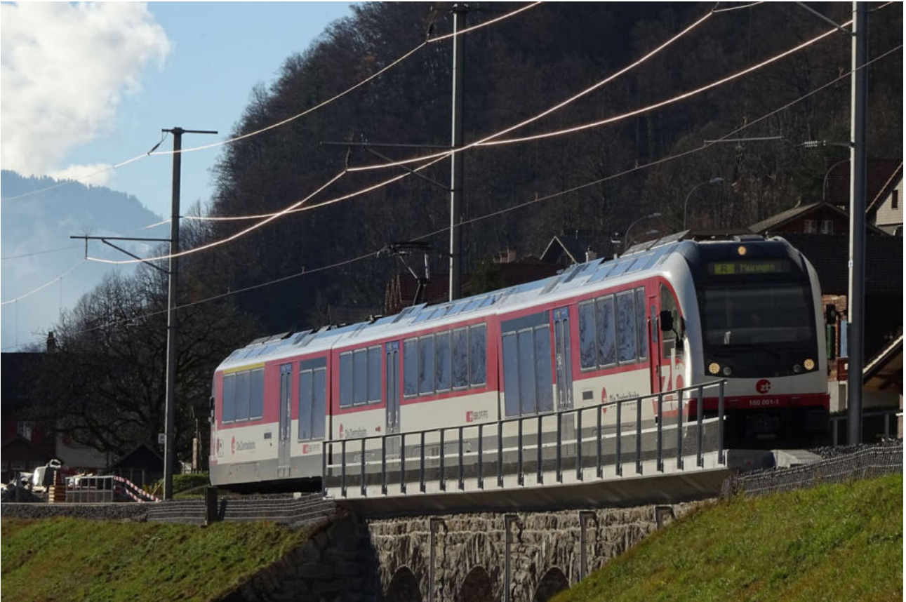
Einer der ersten Züge auf dem frisch ausgerüsteten Viadukt.
