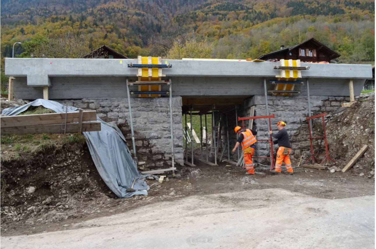
... und die Zwischenräume mit Beton ausgegossen.
