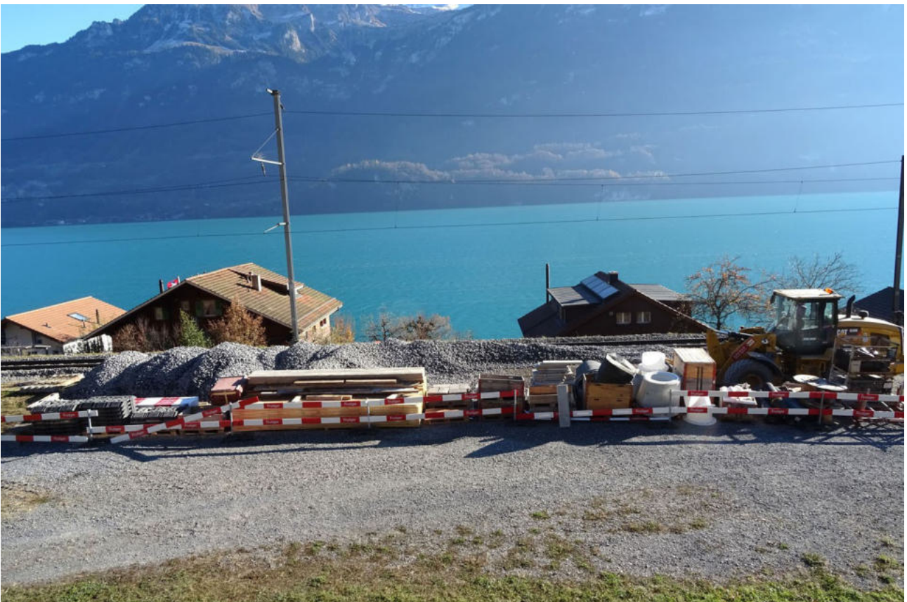
Materialdepot vor der ehemaligen Rampe des Niederrieder Bahnhofs.
