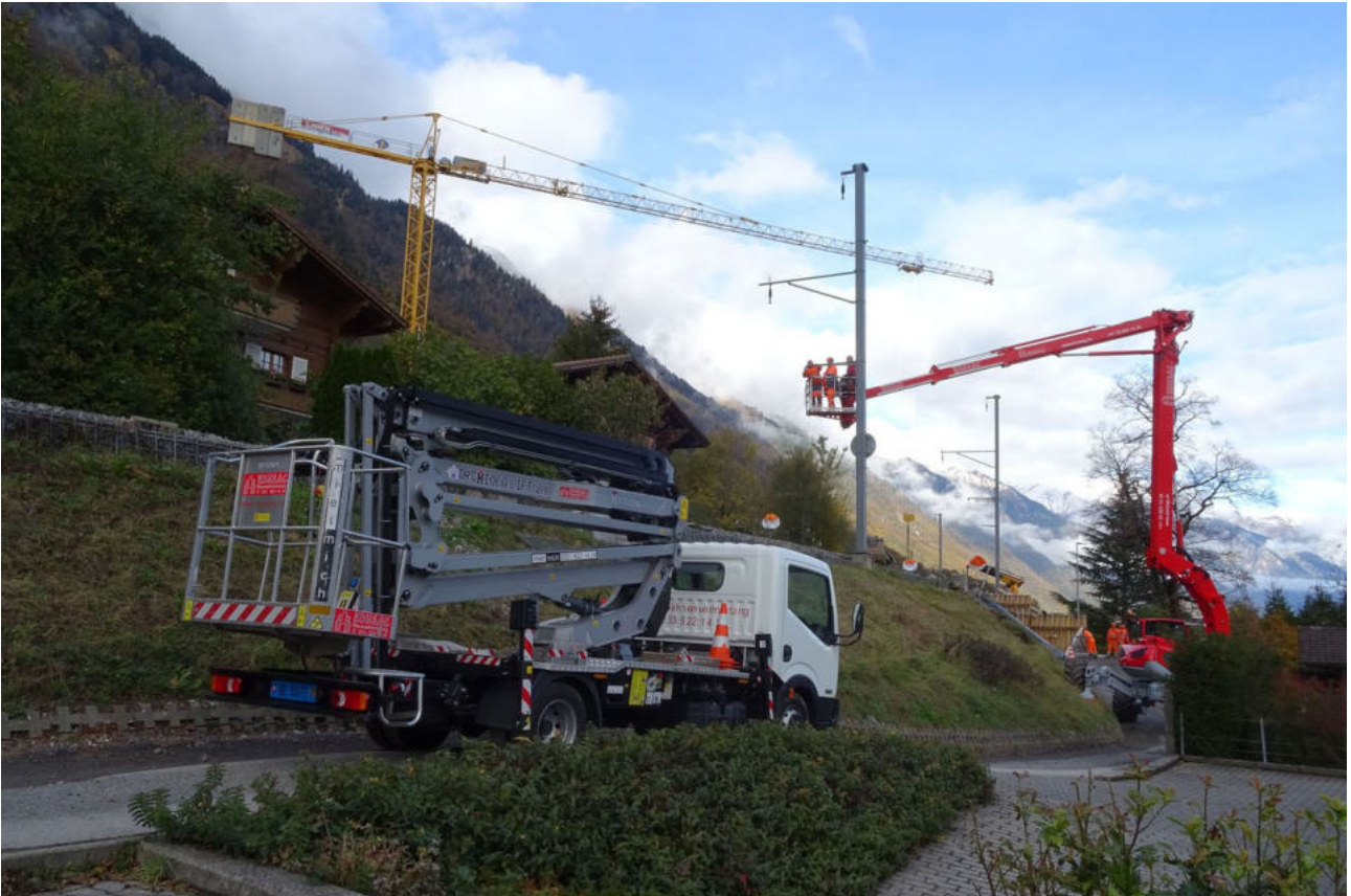
Mastdemontage. Die neuen wurden wie Seilbahnmasten eingeflogen.
