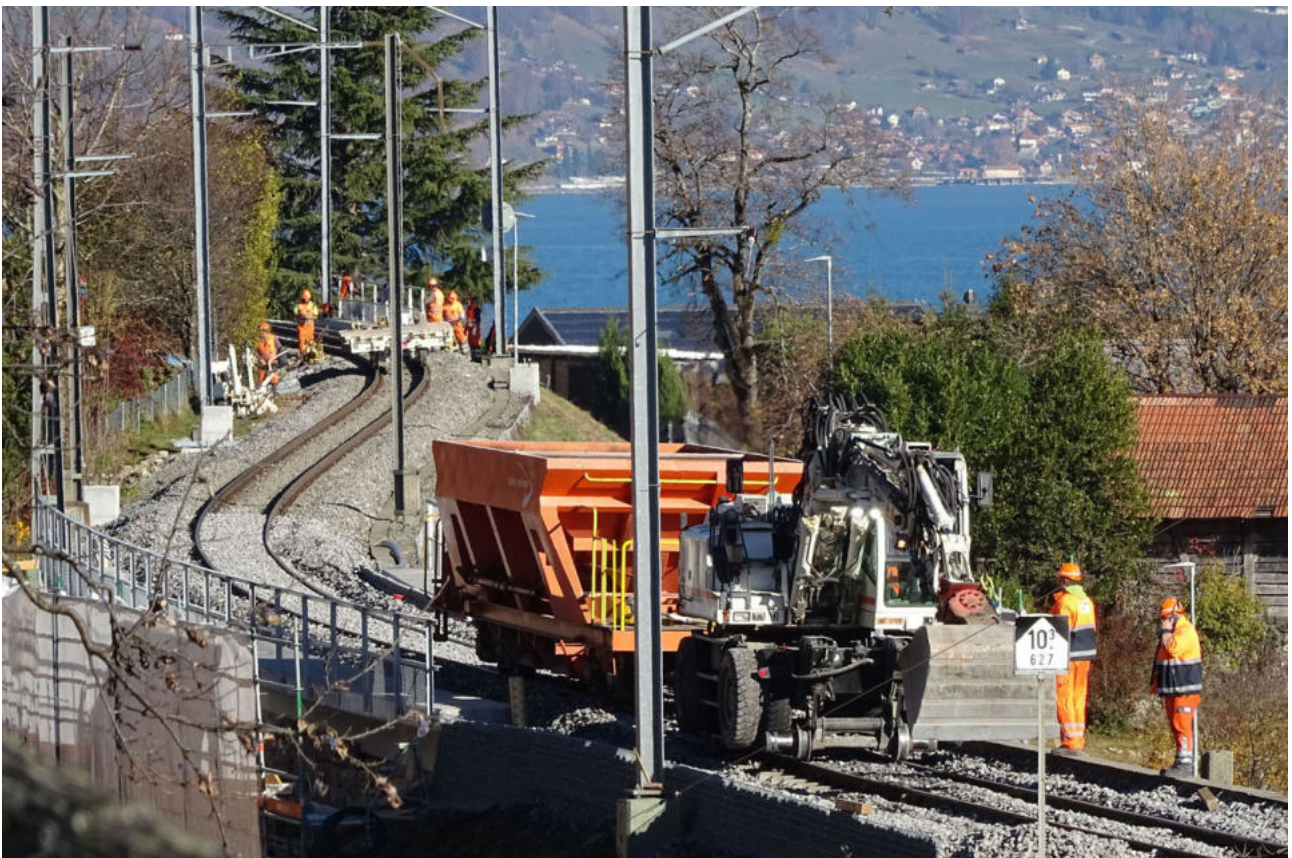
Gleisbau 'von Hand', d.h. ohne einen 400 m langen Bauzug.
