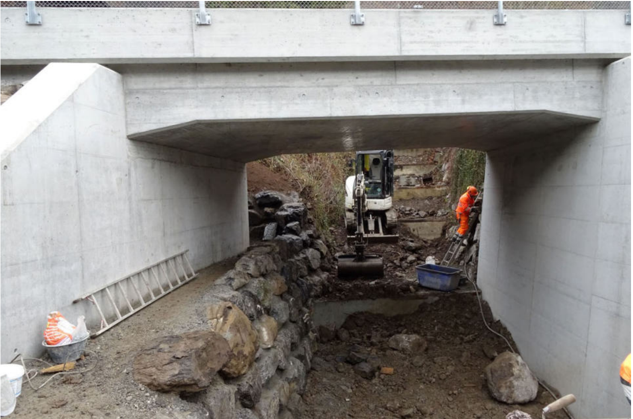
Im Durchlass wurde die Sohle ausgearbeitet und der Fussweg neu erstellt.
